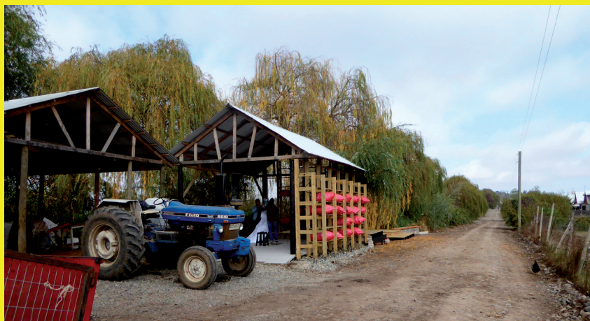
La obra plantea un diálogo con los elementos rurales preexistentes. Fotografía: Rafael Recabal.
